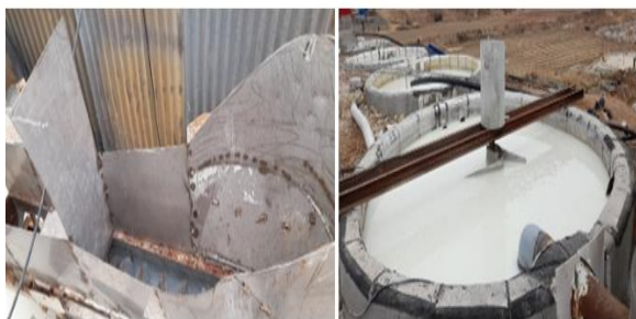
شکل ۱. نمای واقعی مکانیزم پاشش پودر منعقدکننده (سمت چپ) و چهار حوضچه‌ی ته‌نشینی اولیه (سمت راست) در تصفیه‌خانه‌ی کارخانه‌ی تولید نشاسته
