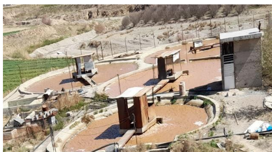
شکل ۲. نمای واقعی چهار حوضچه‌ی هواده‌ی در تصفیه‌خانه‌ی کارخانه‌ی تولید نشاسته
